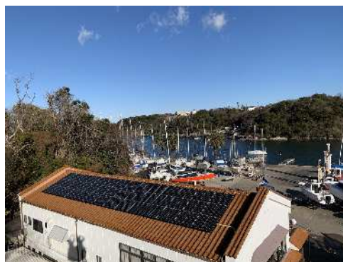
太陽光パネルを設置する油壺京急マリーナ
